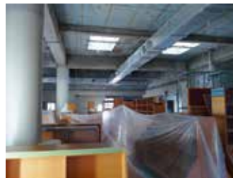
書架を移動させながらの工事
