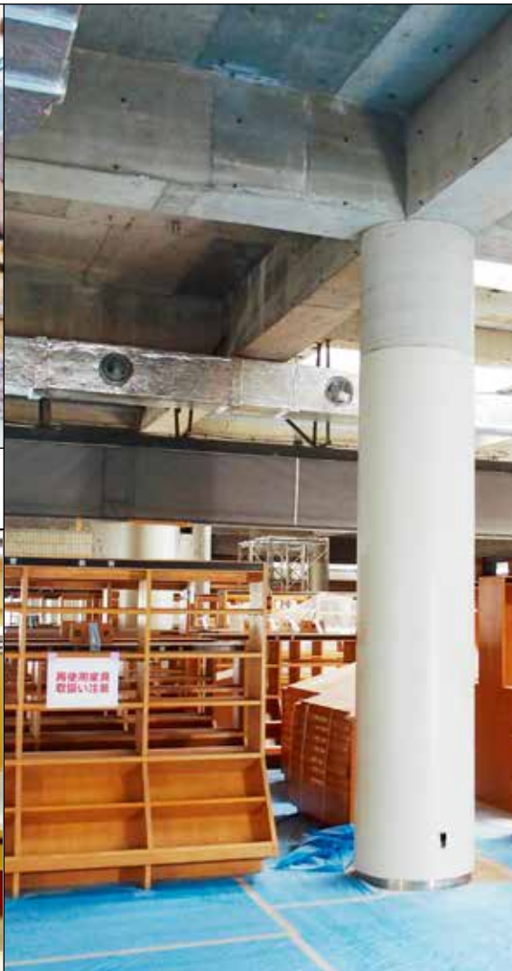
2月、本格的に大規模改修工事が開始
