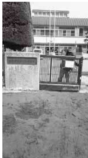
日の出保育園の液状化被害
