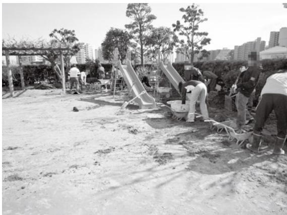
明海幼稚園の復旧作業
