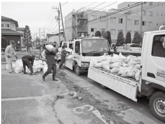
土嚢撤去作業
